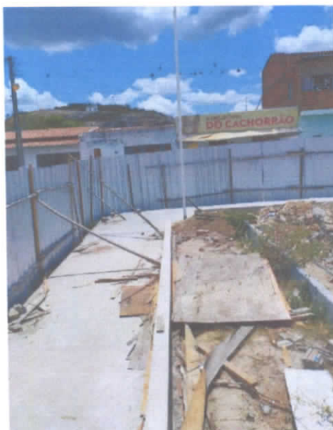
FOTO 13 – POSTE DE ILUMINAÇÃO 1
