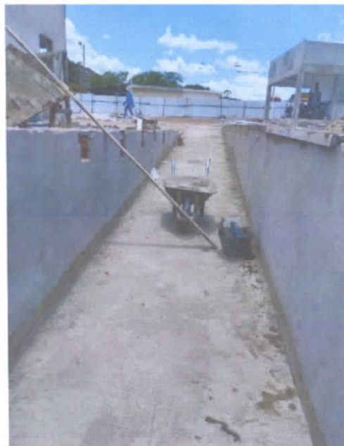
FOTO 7 – RAMPA DE ACESSO 1
